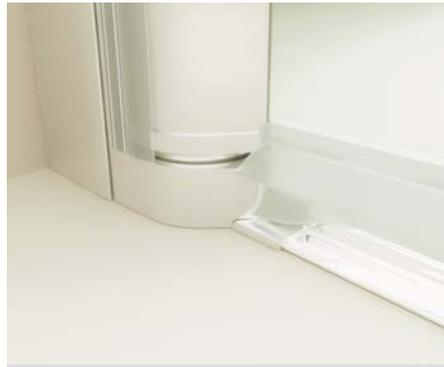
Detalle de la junta lateral interior.
